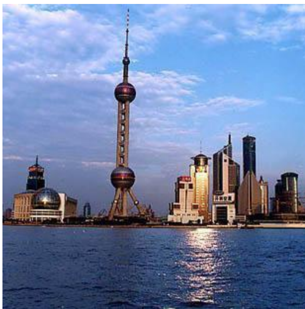
图 1.25: 上海地标东方明珠电视塔。
